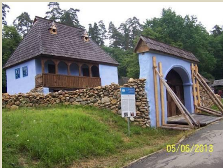
Plaz ogroža eno izmed dragocenih stavb
